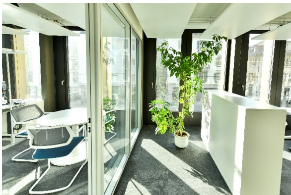
Ausbau Büro im 1. OG (Metall-Akustik/Klima-Deckensegel)
