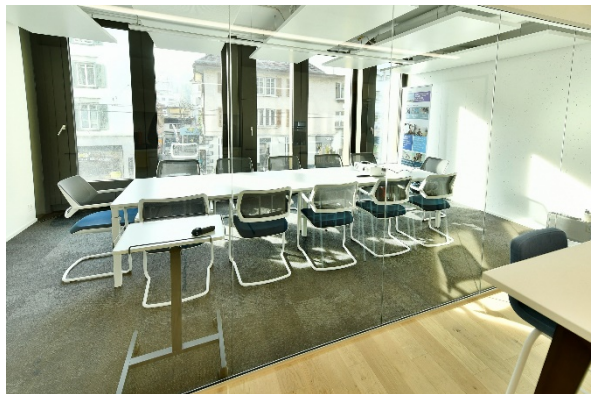
Ausbau Sitzungszimmer im 1. OG (Glas-Systemwand profillos)
