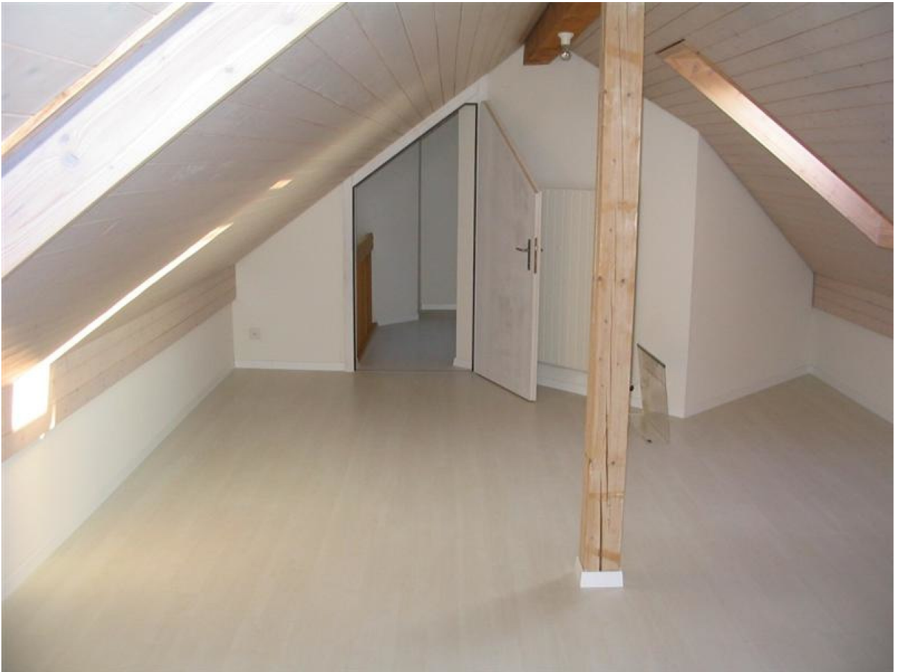
Beispielbild DG Dachstock mit Türe
