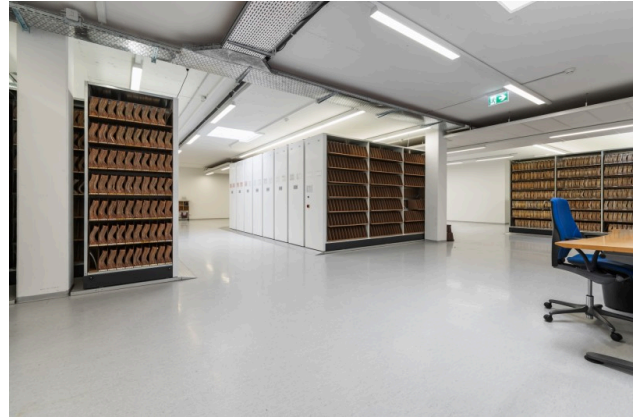
Ausgebaute Gewerbeflächen Objekt 3021
