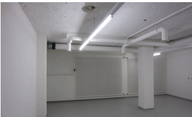
Lager im Untergeschoss
