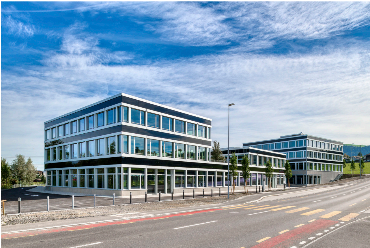
Kreuzung Dorf-, Hauptstrasse in Richtung Dorfzentrum Buchrain
