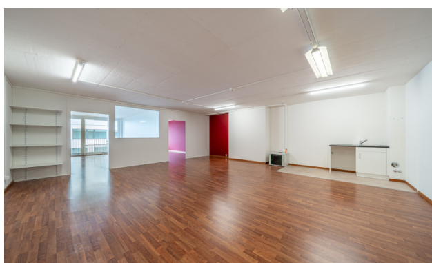
Bürofläche mit bestehendem Innenausbau
