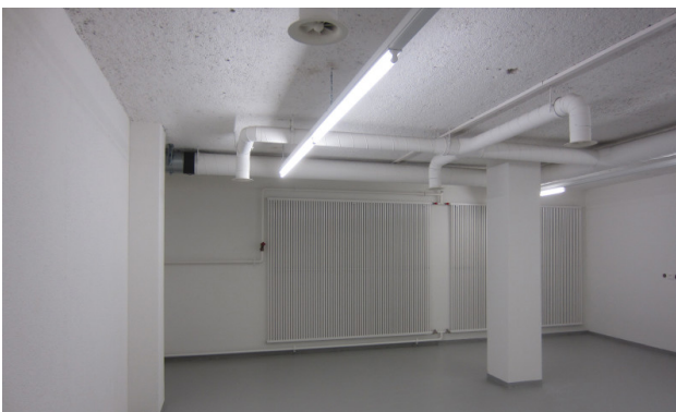
Lager im Untergeschoss
