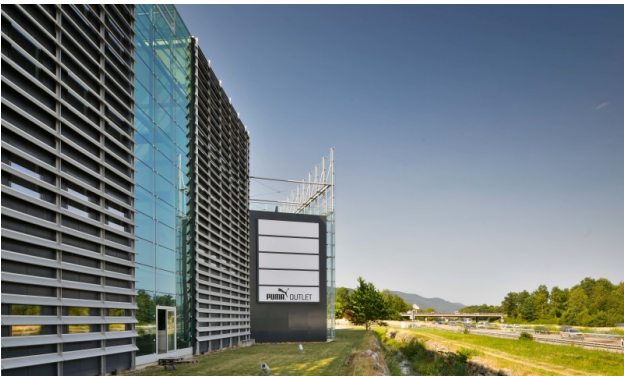
Aussenansicht Richtung Zürich
