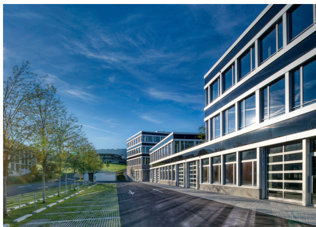
Hochwertige Glas-, Metallfassade
