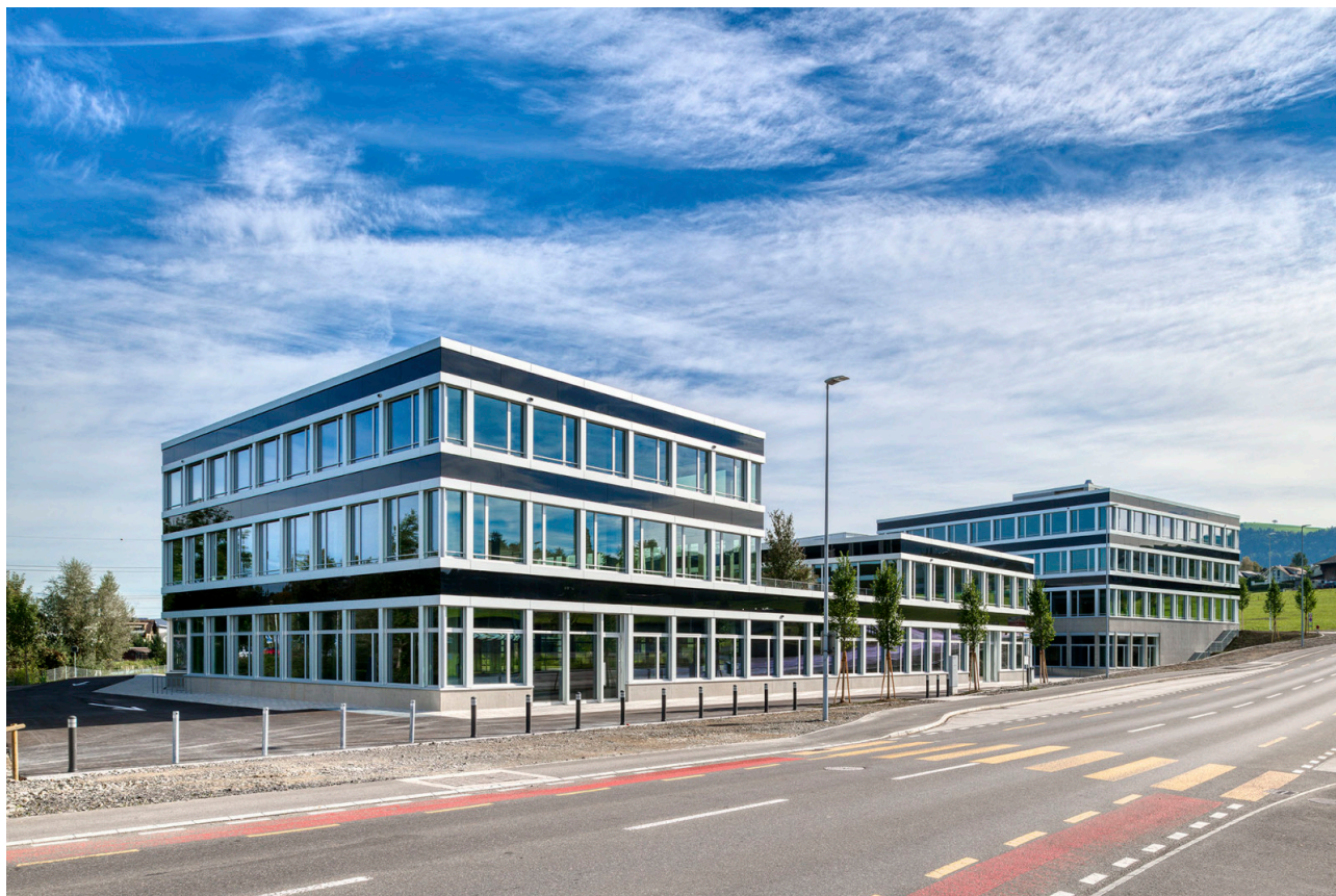
Kreuzung Dorf-, Hauptstrasse in Richtung Dorfzentrum Buchrain
