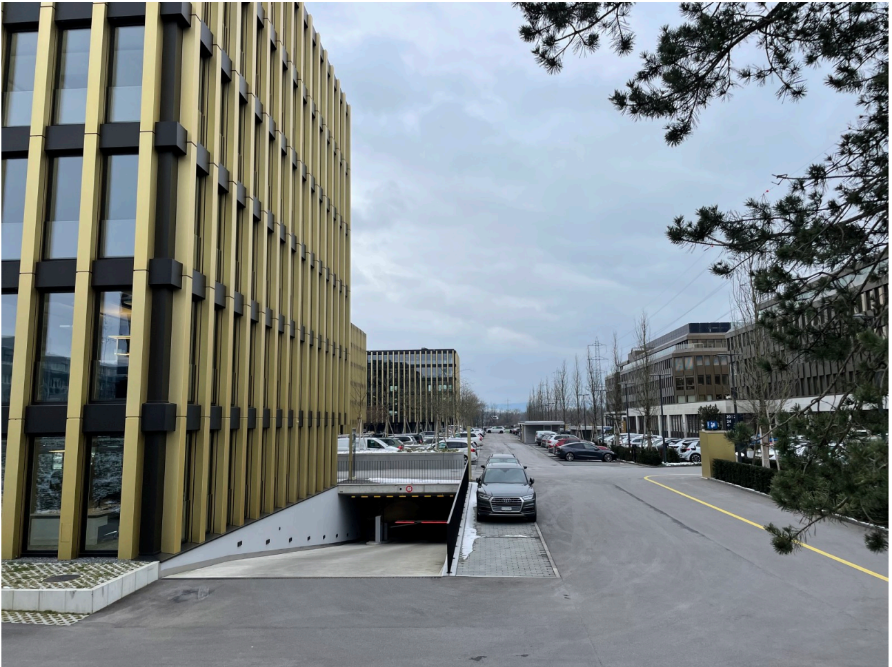
Breite Einfahrt in die Einstellhalle
