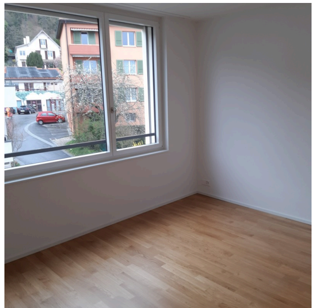
Photo d'un autre appartement du complexe pour illustration
