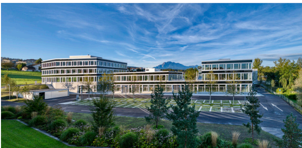
Rückseite der Gebäude 1, 3, 5 mit Pilatusblick
