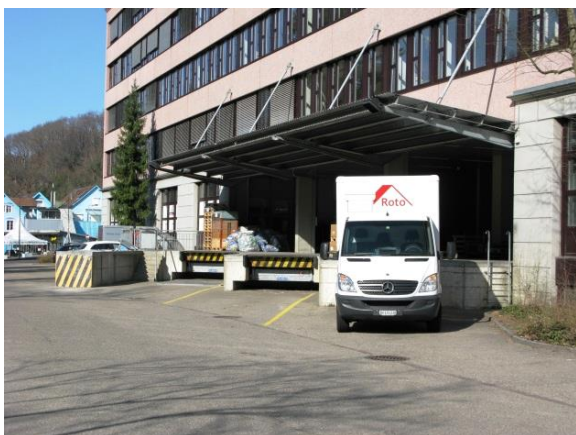
Anlieferung mit Rampen, Hebebühne, Warenlift
